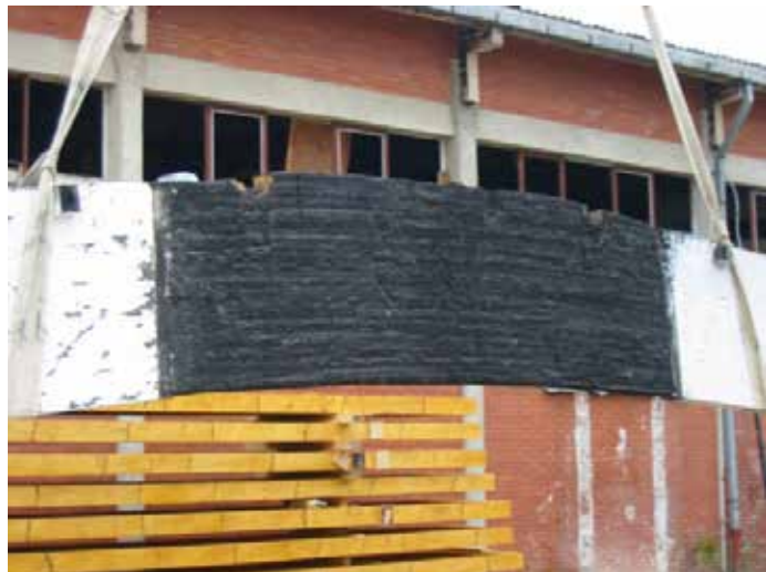
Demontaža izgorjenog lameliranog nosača
