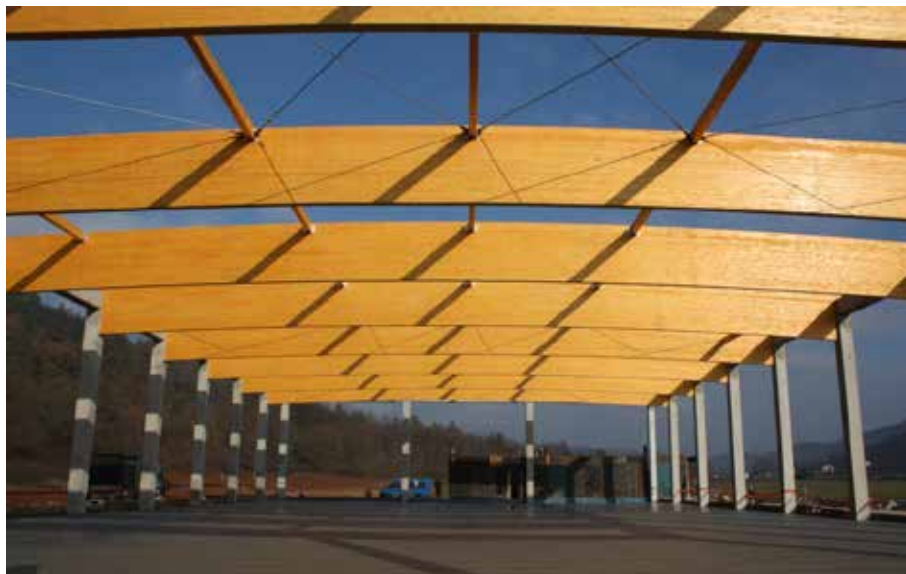
Proizvodna hala. Konstruktivni sustav - prosta greda. Raspon 27,90m.
