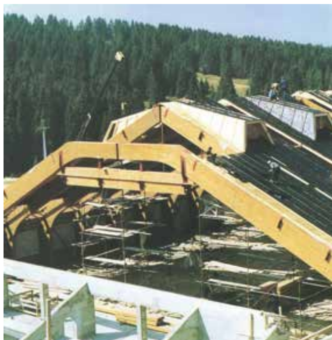
1989 godine izvodimo radove na Športskom centru na Kopaoniku. Raspon konstrukcije je 39,60 m
