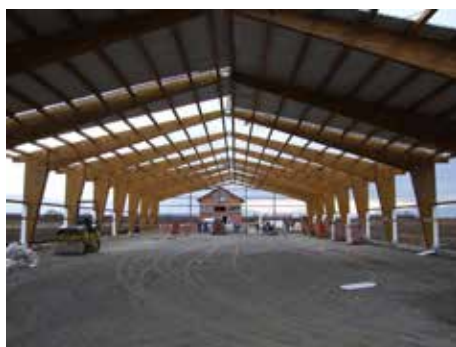
Statički sustav: trozglobni okvir raspona 22,00 m
