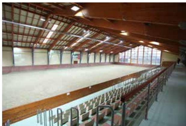
Ergela lipicanaca Đakovo. Trozglobni okvir, raspon 37,60 m. Stupovi - čelik, grede - lamelirano drvo.
