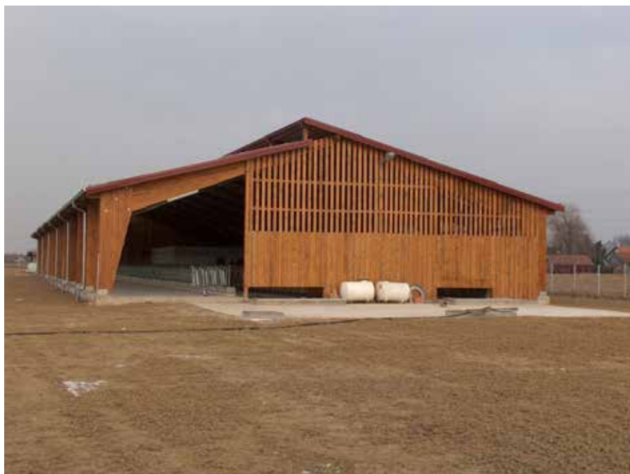
Farma muznih krava - trozglobni okvir raspona 19,00 m.
