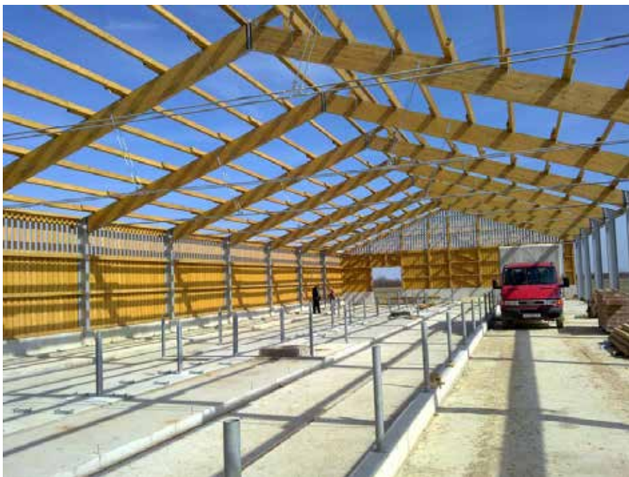
Farma muznih krava - troglobni okvir - raspon 18,10 m. Stupovi - čelični profili, grede - lamelirano drvo
