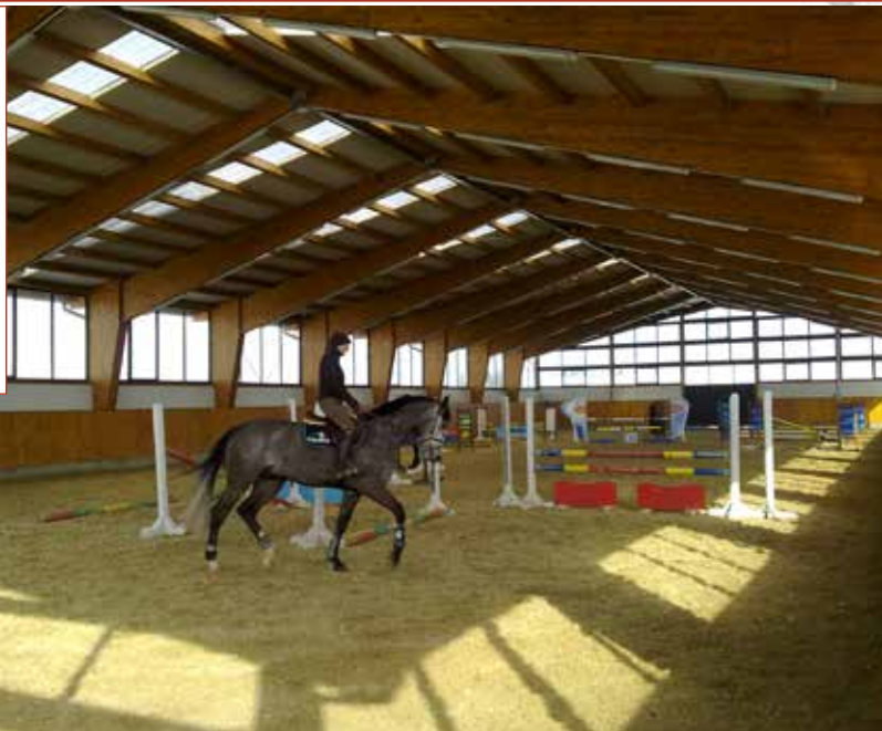
Statički sustav: trozglobni okvir raspona 22,00 m
