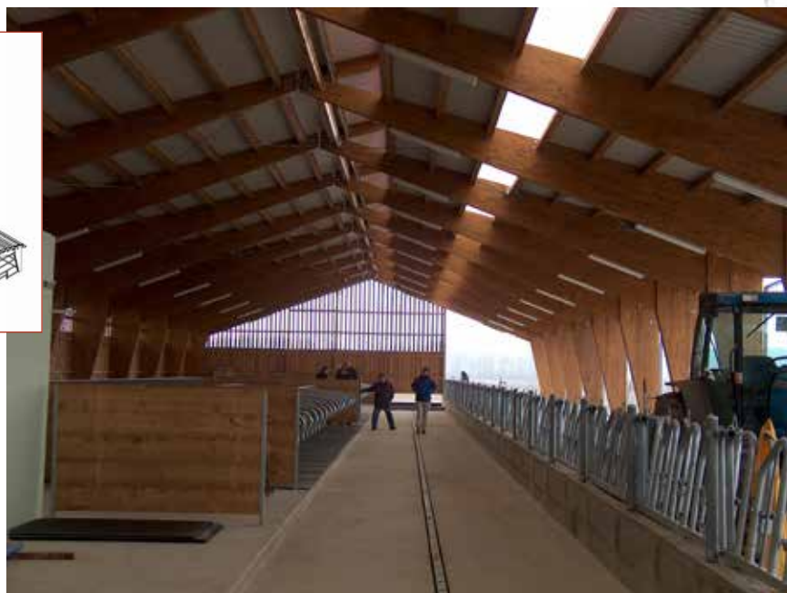
Statički sustav: trozglobni okvir raspona 18,56 m
