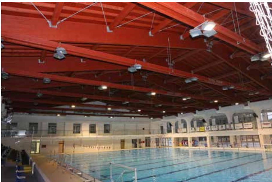
Bazen Korčula. Trozglobni okvir s drvenom zategom. Raspon konstrukcije 31,50 m.
