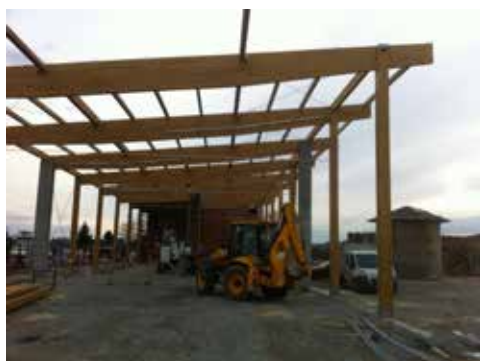
Statički sustav: okvir na pendl stupovima raspona 16,00 m
