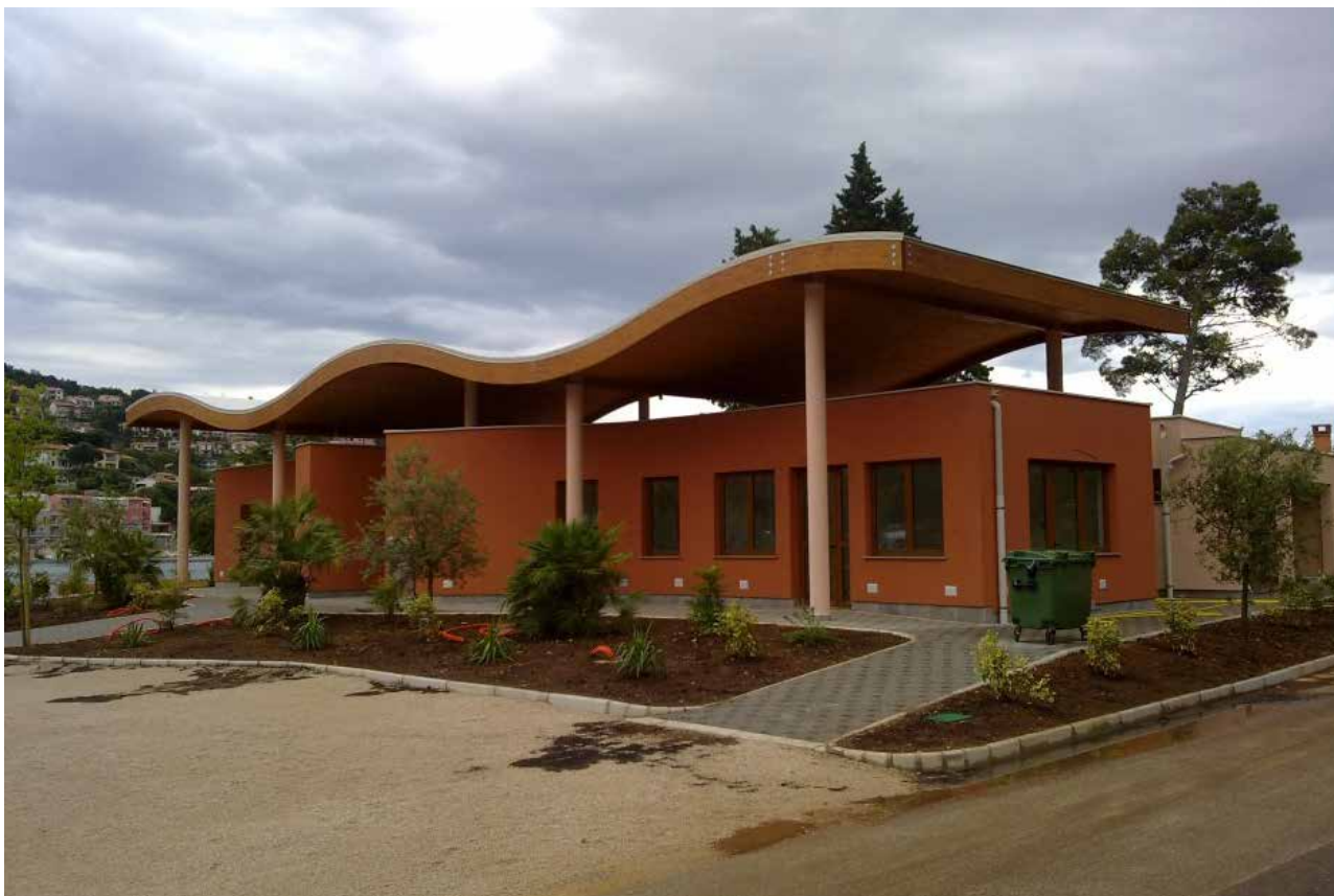
Turistički objekt u Rabcu - konstrukcija u obliku vala. Dimenzija objekta 14,65 x 9,00 m
